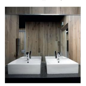
sont très importants pour offrir une meilleure expérience aux visiteurs". Grâce à la technologie infrarouge des robinets électroniques, les visiteurs évitent tout contact manuel, réduisant ainsi la transmission de germes. De plus, ces robinets sont également équipés d'un rinçage périodique antiprolifération antibactérienne qui est activé toutes les 24h après la dernière utilisation, afin d'éviter la stagnation de l'eau.
