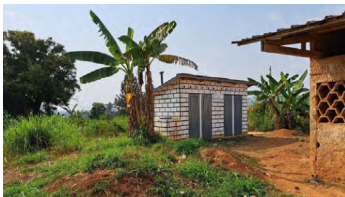
Mbankomo in Kameroen. Bouw van vier ecologische latrines in twee scholen. ©UNICEF
